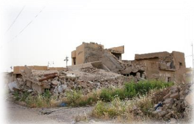
Das zerstörte Telskuf
